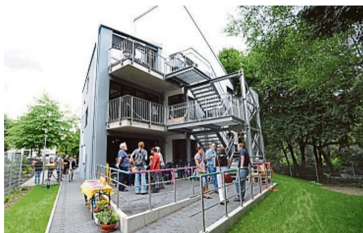
Die schöne Lage in der Nähe zur Wupper wurde dem Hephata-Wohnheim (hier bei der Eröffnung 2012) in der Flutnacht zum Verhängnis.
